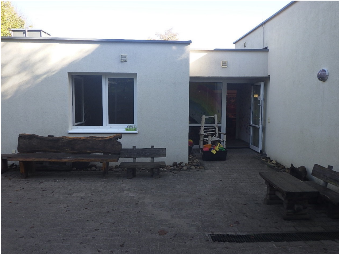
Abbildung 17: Beispiel eines bodentiefen Eingangs des Kath. Kindergarten Hermann Striebel (Ortsbegehung am 27.10.2022)
