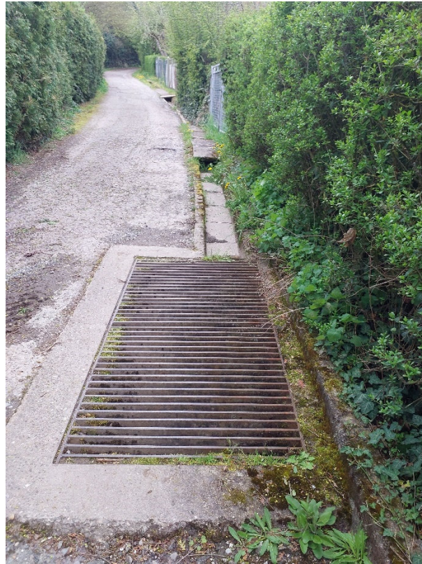
Abbildung 22: Bereich der Maßnahme 1.4 Burgweg (Ortbegehung am 18.04.2023)
